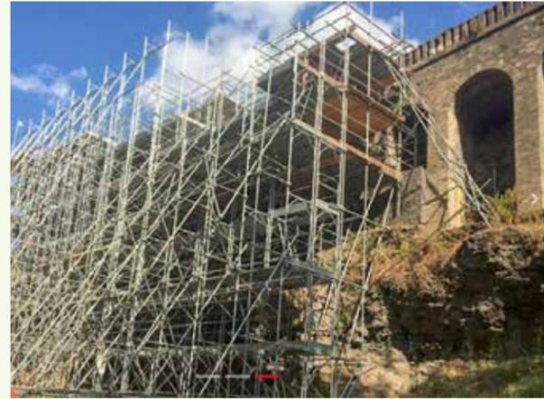
MODELLO PONTEGGIO A TELAIO PREFABBRICATO
